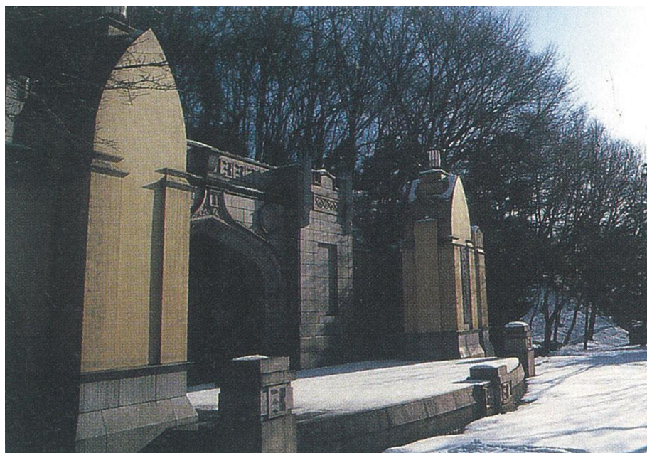
神田駿河台から多摩キャンパスに移築した中央大学の象徴 白門
